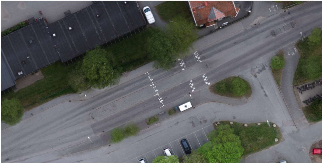
Figur 14. Bild över hastighetsdämpande åtgärder (vägvsmalningar och gupp) för väg 1937 (Lerumsväg) genom Olofstorps kärna
