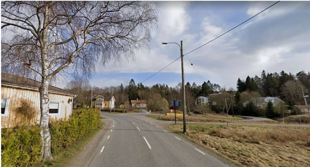
Figur 19. Plankorsning mellan väg 1937 och GCM-väg i Stenared, vy norrifrån med dålig sikt från vänster.
